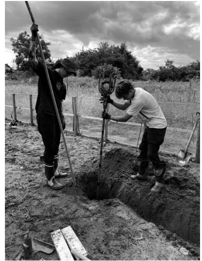
Photo.8 HP 埋設の様子
