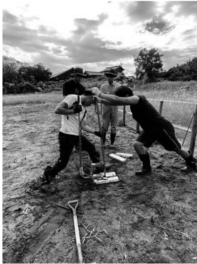
Photo.7 掘削の様子(杭抜き)
