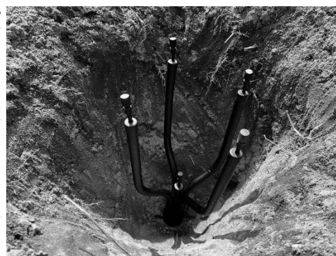
Photo.5 埋設した HP
